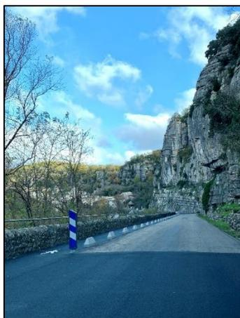
Une première tranche est finie. Elle démarre de l'ancien camping jusqu'au village. Une bande piétonne réalisée en goudron bi-couche avec des plots béton pour sécuriser les piétons est achevée ainsi que les zones de croisement pour les véhicules. La peinture indiquant le marquage de la zone piétonne a été effectuée. Reste la pose de la résine en damier pour les passages de croisement.
